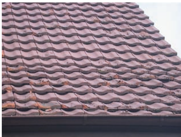
Schadhafte Beschichtung
